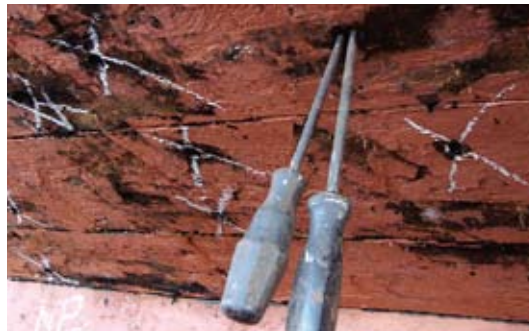
To kraftige skruetrækere slås ind ved kanten af spigerhovedet.
