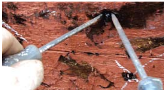
Ved at brække over undersænkningens kant løses spigereets greb.
