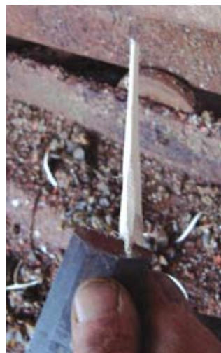
Hvis der ikke er noget materiale at bore i, snittes en konisk fyrrepind, der slås i det gamle spigerhul.
